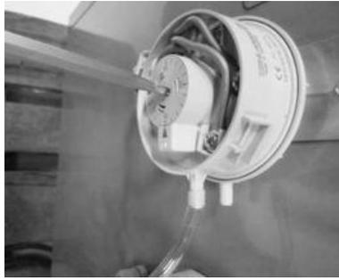
9. Mit Schraubendreher die Kunststoffabdeckung abnehmen, falls Einstellungen zum Filtertausch angepasst werden müssen.
