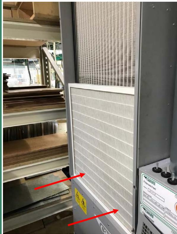
12. Vorfilter an Dichtung des Rahmenmoduls setzen.
